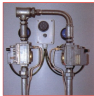
A két elektromos gázszelep felezett teljesítményű működést is lehetővé tesz.
